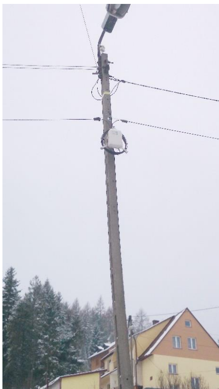
Rys. 1 przykład instalacji kabla i nastupowej szafki abonenckiej
